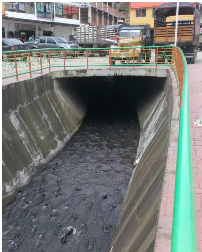
Canalización de la quebrada Arrayanal en la plaza principal de Mistrató.
