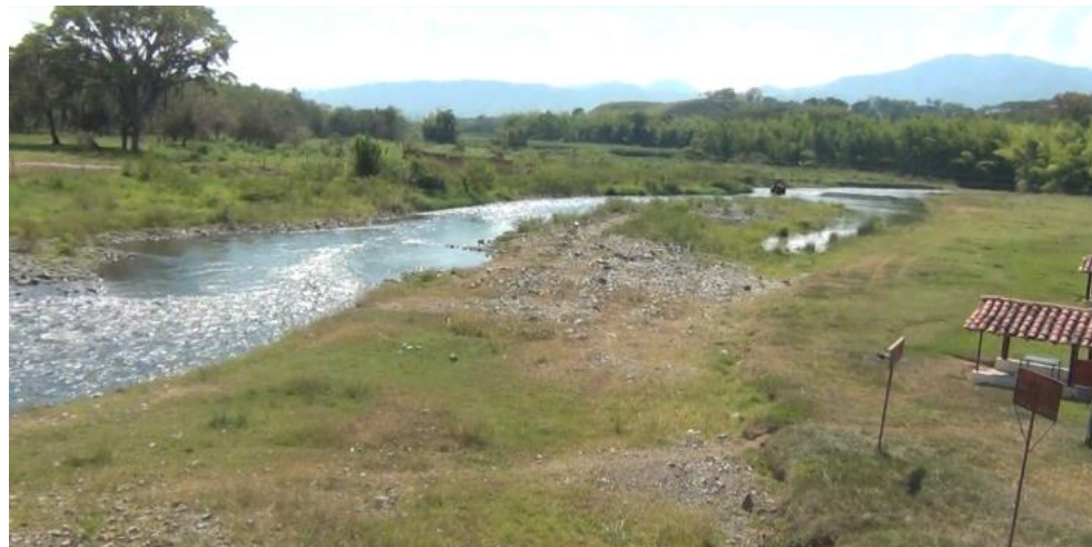
Figura 23. Cauce del río Risaralda abajo del Puente de La Isla, nótese la característica torrencial del sector Fuente: Consorcio Ordenamiento Cuenca Risaralda 2016.
